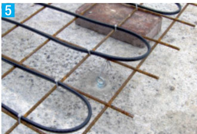
5) Particolare del fissaggio tramite fascette
